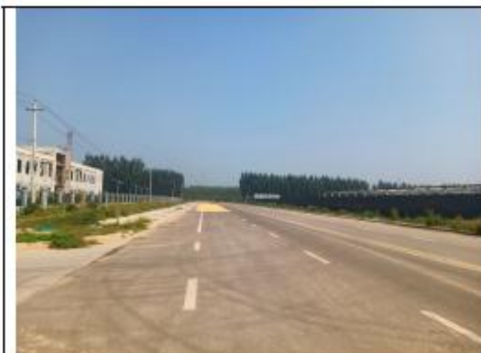
厂区进厂道路
