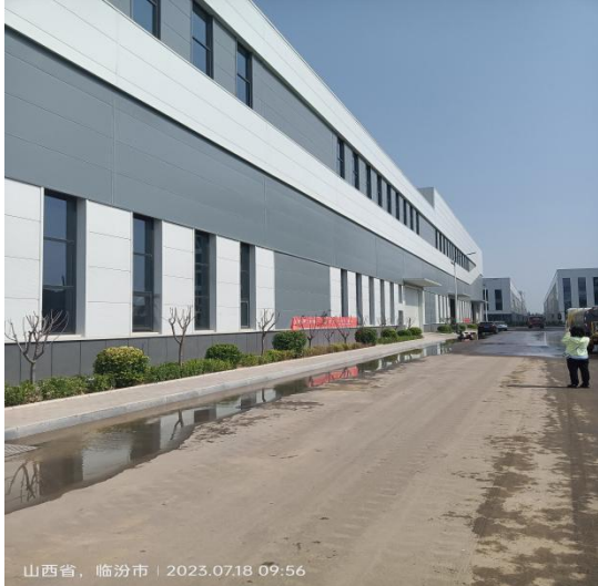
图3 项目东侧车间现状
